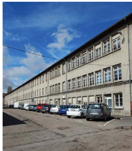
Le bâtiment nord.
